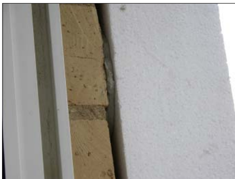
Mangel 1: Die Kleberwülste müssen ca. 5 cm breit und in Wulstmitte mindestens 10 mm dick sein. Der Achsabstand darf 10 cm nicht überschreiten. In der Praxis werden oft keine „Wülste“, sondern nur „Kleckse“ aufgebracht.
